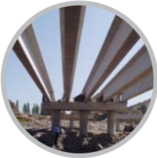
DEFINICION GEOMETRICA VIGA BN-80 0.833 T/m.A
