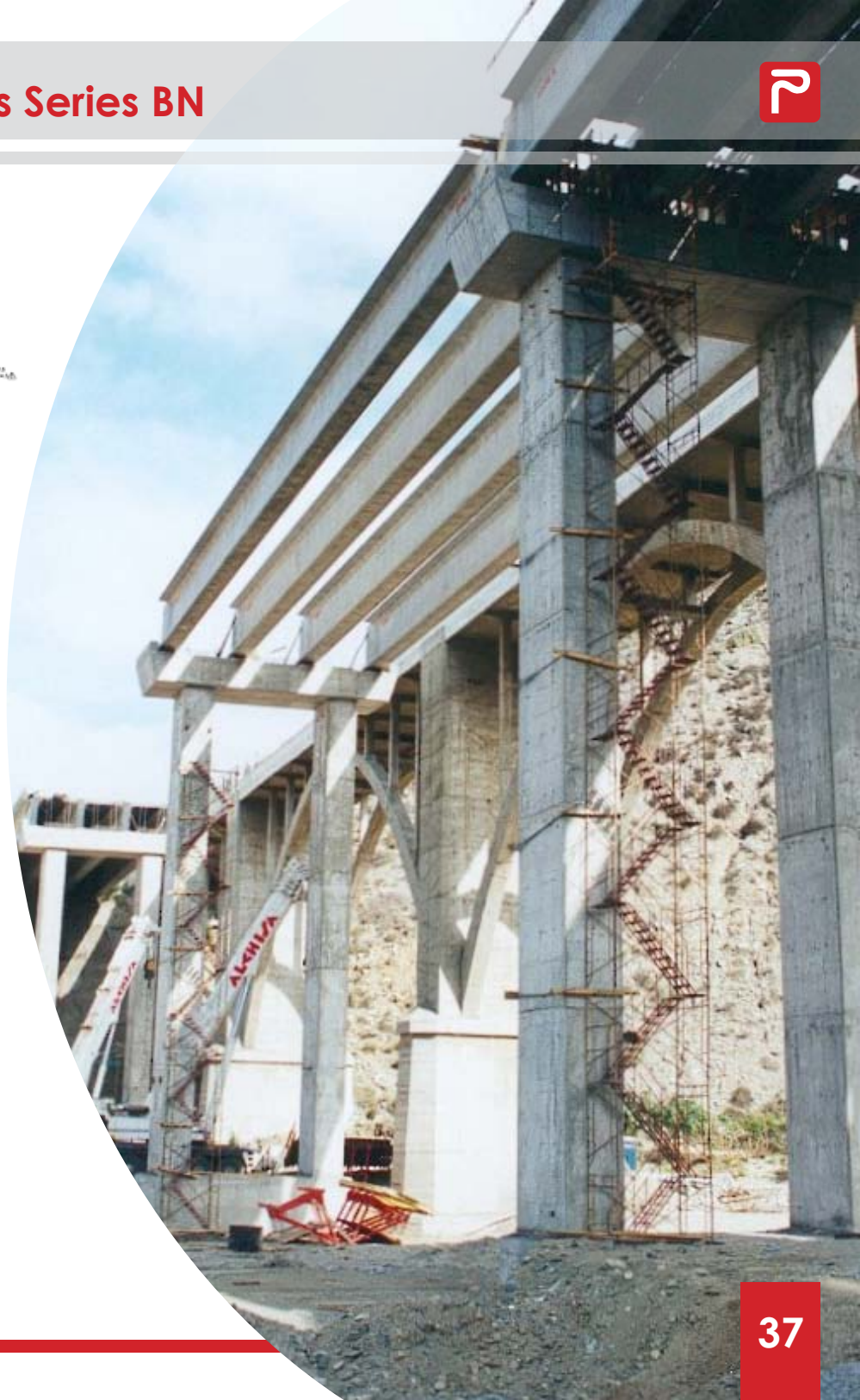
DEFINICION GEOMETRICA VIGA BN-130 1.266 T/m.A
